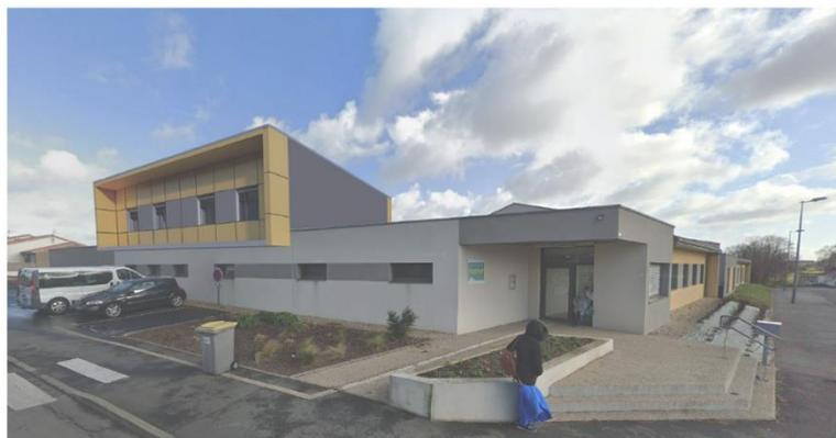
La surélévation par une structure bois sur le garage actuel s'est imposée afin de créer une volumétrie supplémentaire sans reprendre la structure existante.
